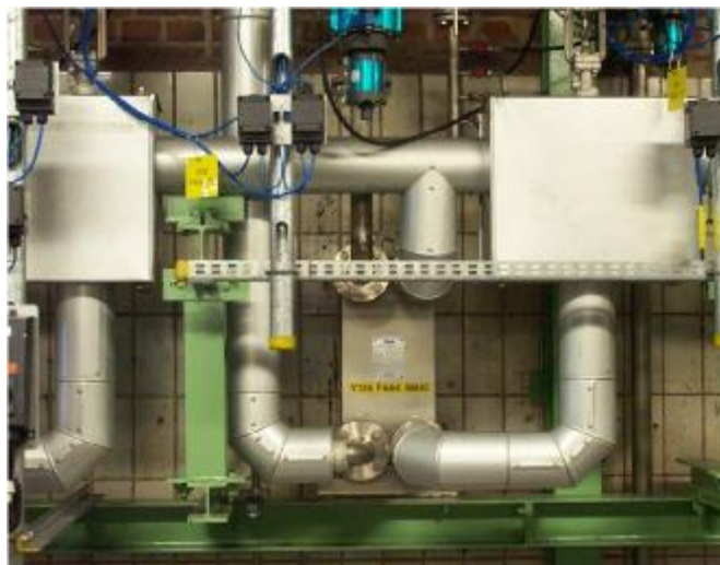
SIGMAWIG ST12 w obwodzie chłodzącym reaktora chemicznego.
