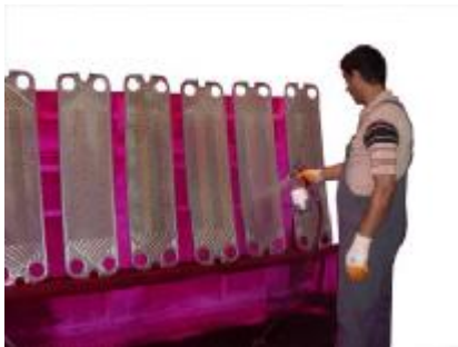
Kontrola szczelności płyt
