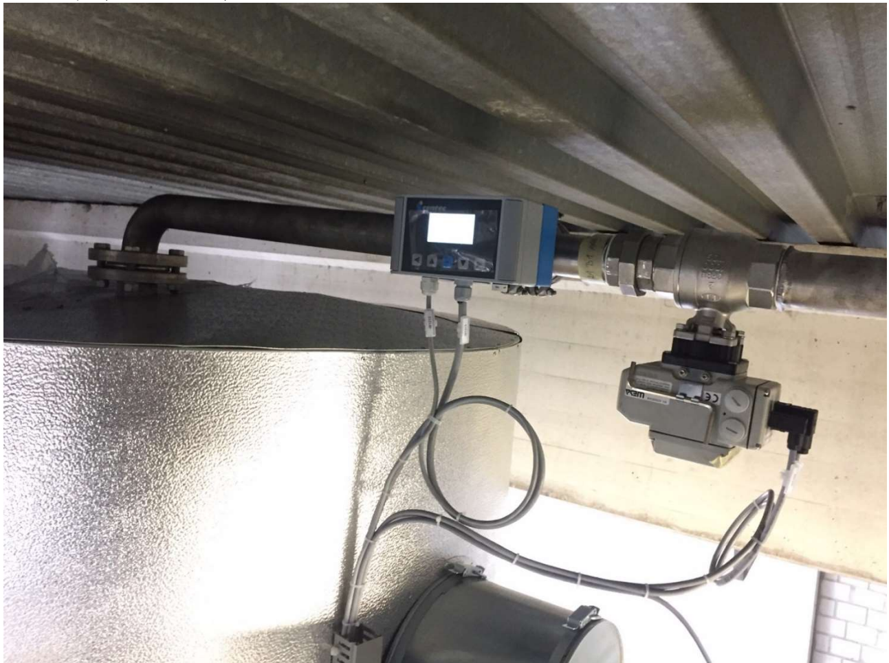
Einbaubeispiel (Sensor und Ventil)
